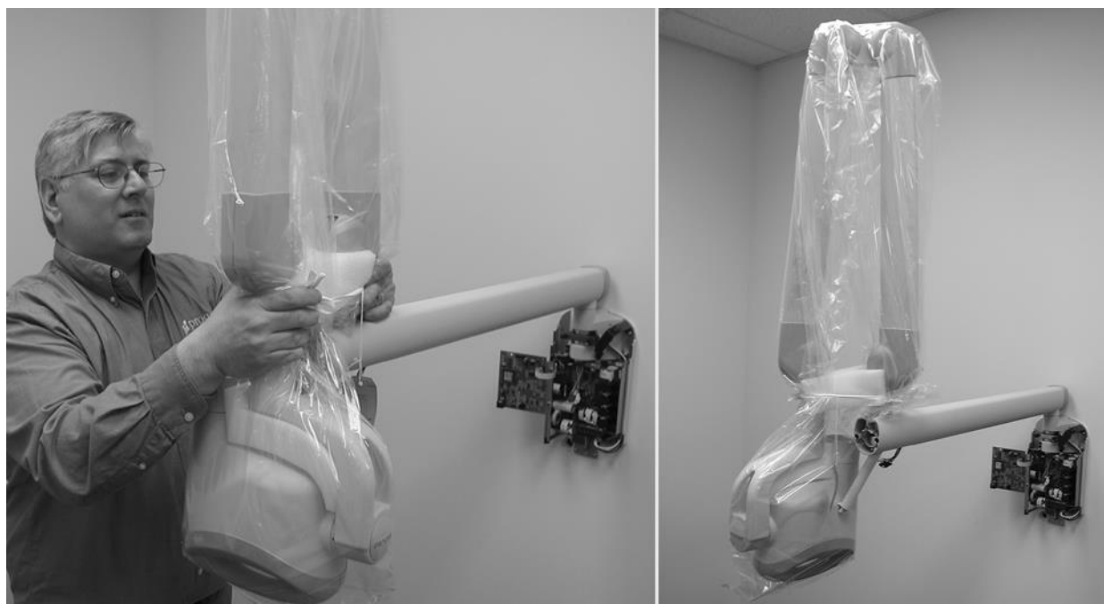
Rysunek 20 Montaż zespołu ramienia łamanego i lampy
